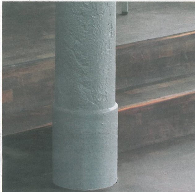
Een pilaar, geschilderd met brandwerende coating. Alleen de losse verfdelen zijn verwijderd, op verzoek van de architect
