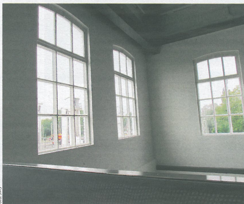
Aan het beton van de ramen mocht Manders Totaal bij hoge uitzondering wel wat betonreparatie uitvoeren, zodat het monumentenglas er strak in kon worden gezet
