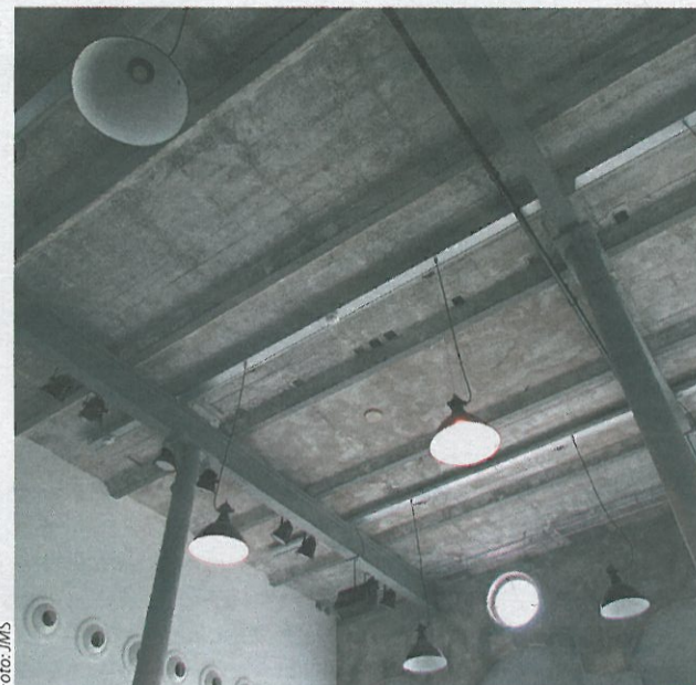
De betonnen plafonds zijn alleen gereinigd. Verder zijn ze geheel onbehandeld gebleven
