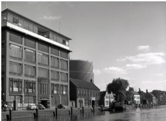
Industriële architectuur Kanaaldijk Helmond
