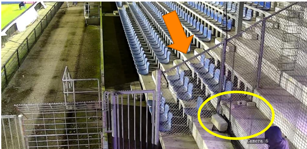
Figuur 8. Laag hekwerk bij het buffervak (pijl) en losliggende stenen op het net (omcirkeld)
